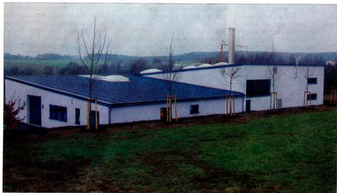
Arbeiten abgeschlossen: Im Krematorium im Gewerbegebiet wurden die ersten Einäscherungen bereits vorgenommen. Foto: Axel Munsteiner
